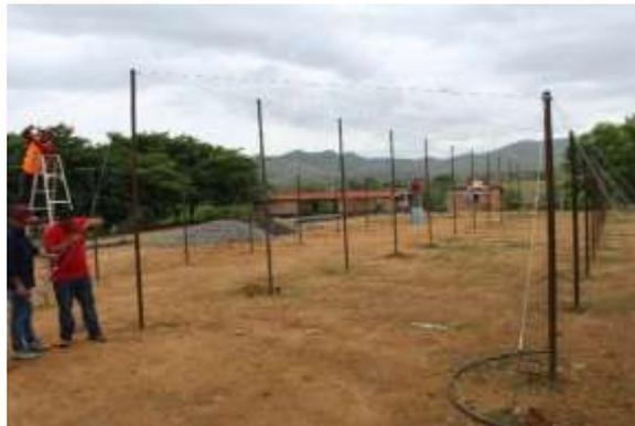
Fig. 22 y 23 Trazado del vivero y excavación de hoyos para colocación de postes de acero y retenida de varillas y cemento.
